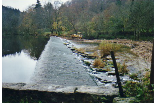
Zustand vor dem Umbau
